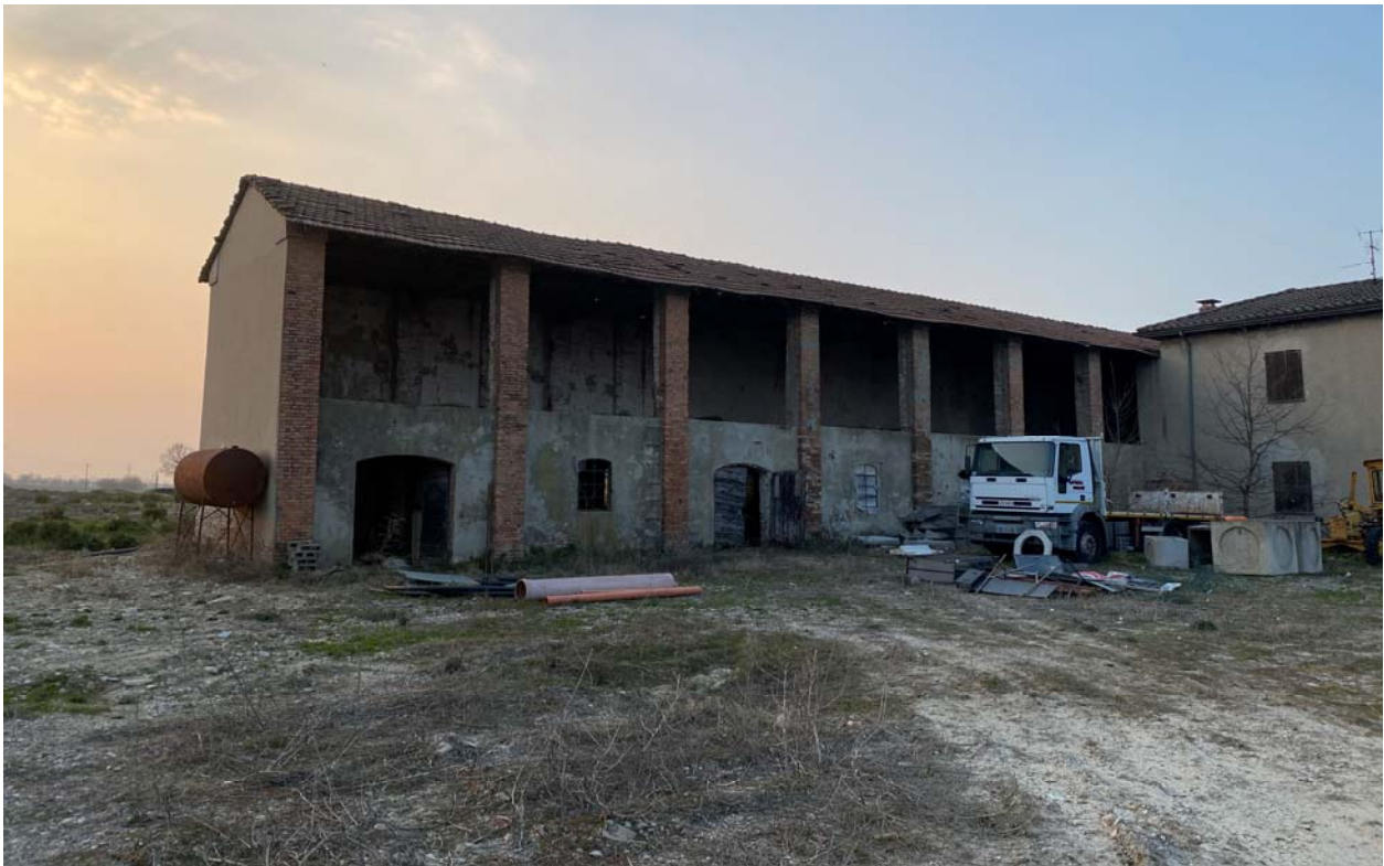
Il fabbricato che completa il lato ovest - vista dal nucleo
