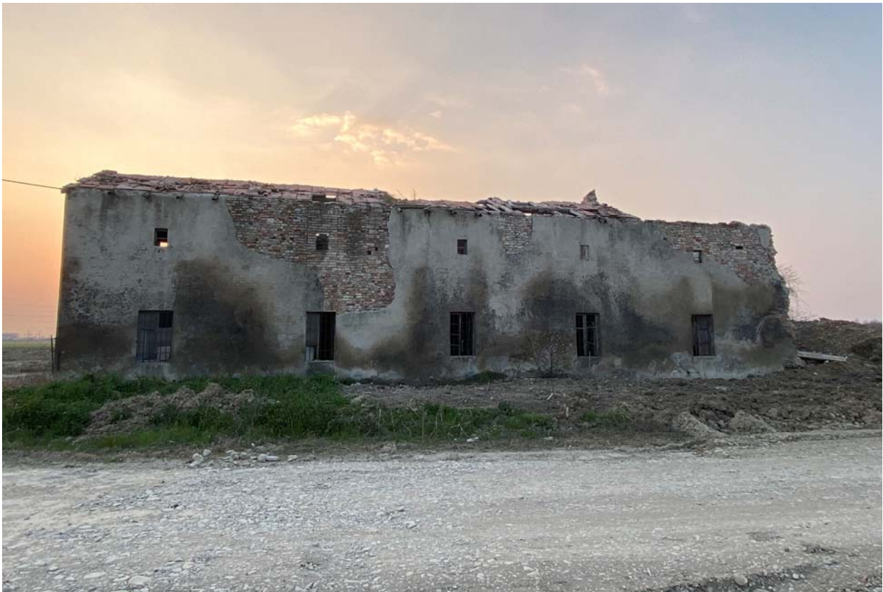
Il fabbricato che completa il lato est - vista da est
