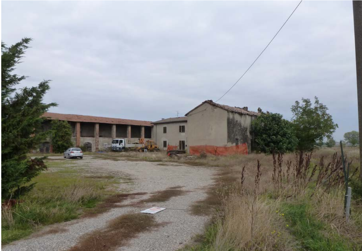
Il complesso dei fabbricati
