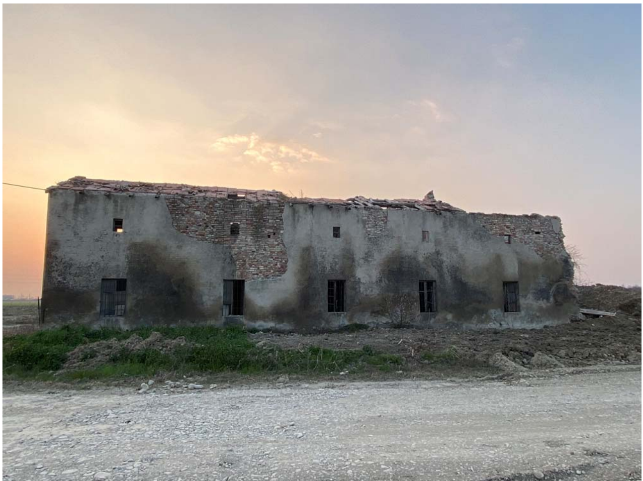
Il fabbricato che completa il lato est - vista esternamente
